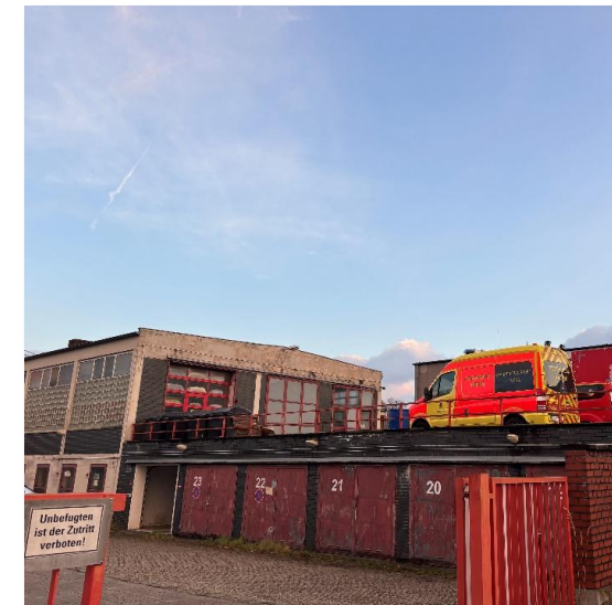
Höhenunterschied im Norden, Tiefgarage vorhanden
