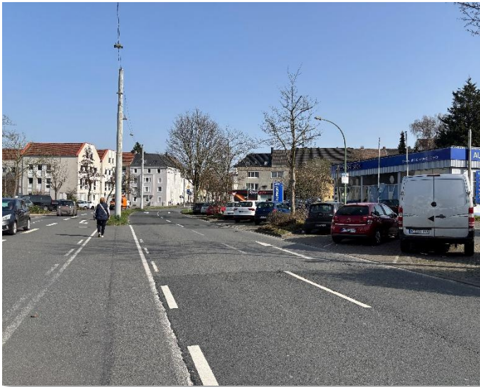
Fehlende Querungsmöglichkeiten für Fußgänger*innen
